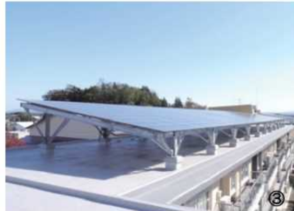
写真 ①外観（改修後）②外観（改修前）③屋上に設置した太陽光発電パネル
