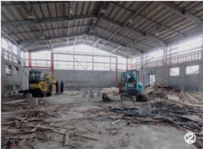
写真 ①既存体育館の鉄骨骨組みのみ残した状態 ②既存体育館の鉄骨骨組みのみ残し解体中 ③屋根材、外壁材、内装材等の改修中
