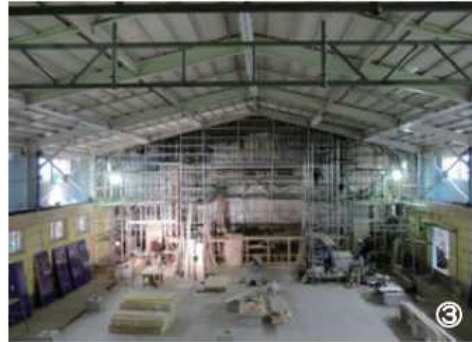
写真 ①既存体育館の鉄骨骨組みのみ残した状態 ②既存体育館の鉄骨骨組みのみ残し解体中 ③屋根材、外壁材、内装材等の改修中
