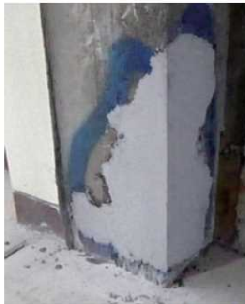
はつりとした部分に無収縮モルタルを塗付
