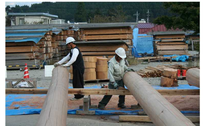
地元大工による丸太材の加工
