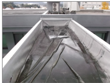
屋上防水（修繕前）
