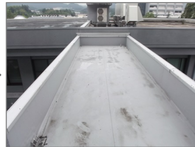
屋上防水（修繕後）
