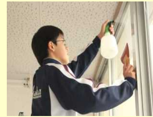
ガラス飛散防止シートの貼付
