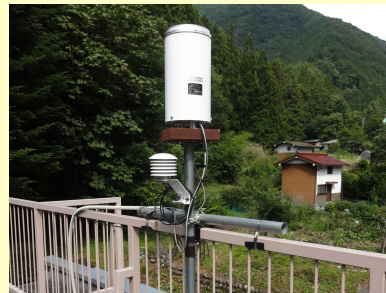
校舎屋上に設置された雨量計
