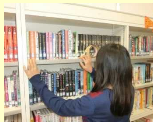
落下抑制テープの貼付
