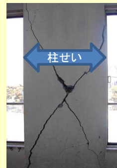
極短柱のせん断破壊
