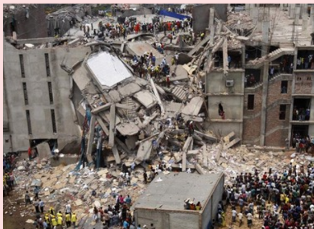
ラナプラザの倒壊事故
