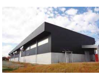
図 26(蓄電デバイス開発研究センター、H26 開所)
