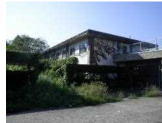
図 27 (啓明寮 改修前)
