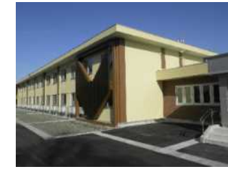
図 28 (啓明寮 H24 改修後)
