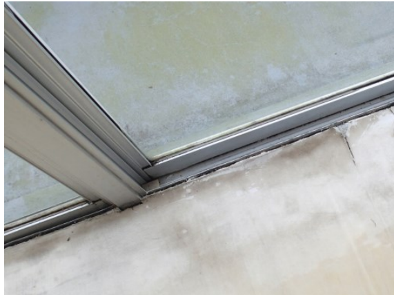
写真 床シート やぶれ／要補修
