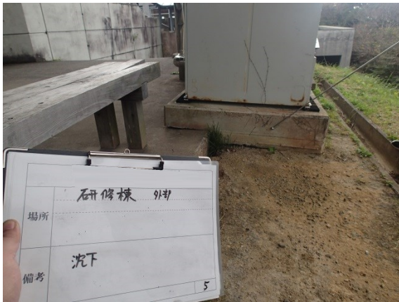
①不同沈下により設備等が傾いている
