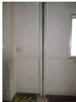
②不同沈下により上下の隙間の幅が異なる
