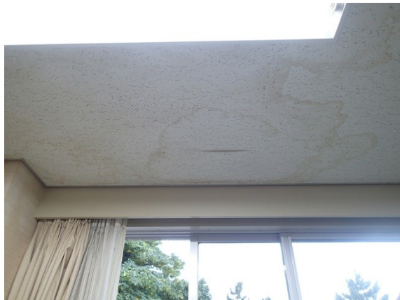
写真 天井材の剥がれ/要是正
