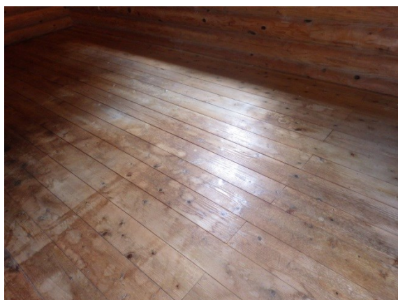
写真 フローリングの劣化／要是正
