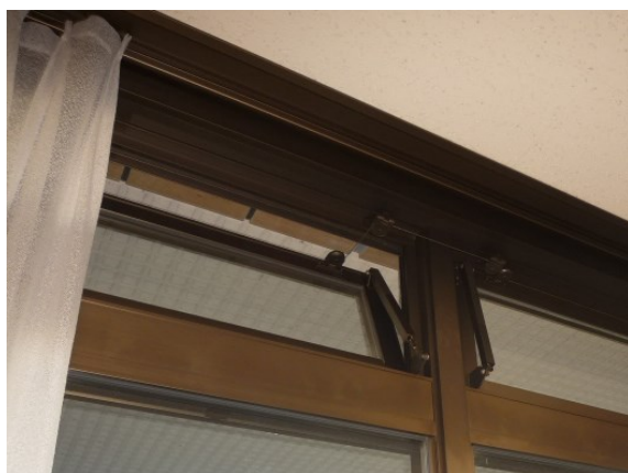
写真 開閉不具合（部材の劣化）／要調査
