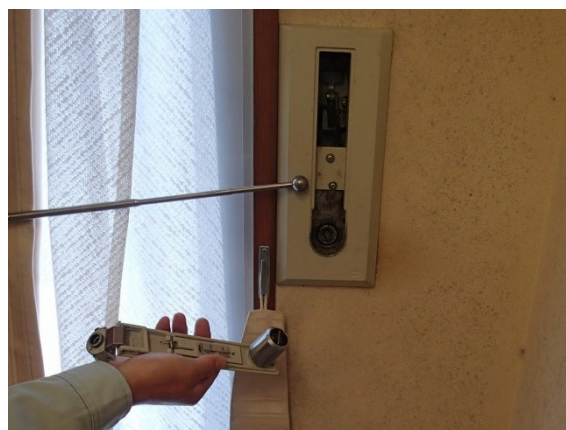
写真 自動開閉装置状況
