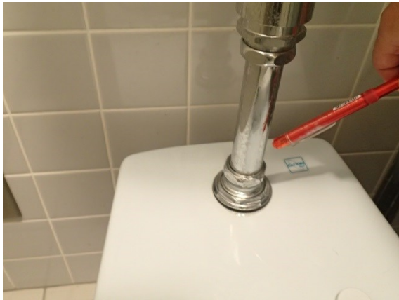
写真 水漏れ(水栓)／要是正
