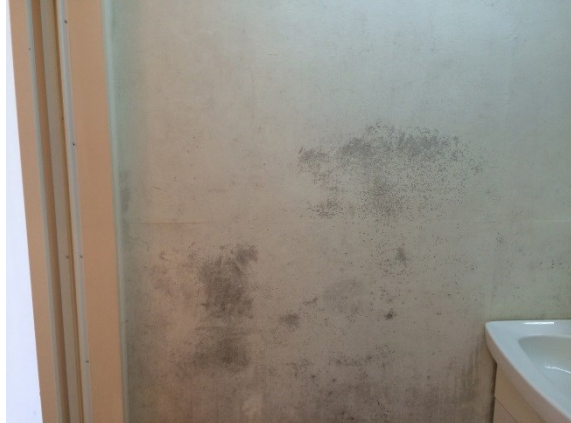
②浴室、洗面脱衣室等の湯気が充満する部屋
