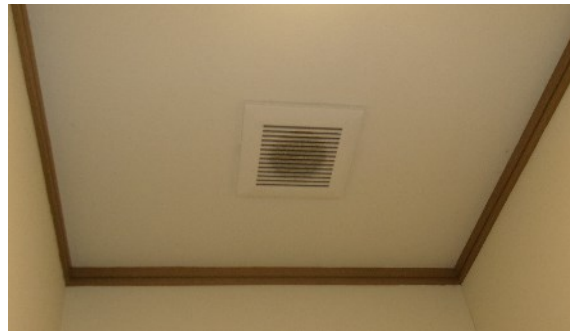
写真 吸気口の目詰まり/要是正
