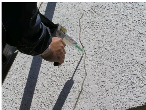
写真 壁の補修状況
