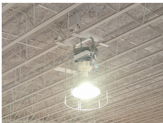
写真 照明器具（正常な状態）
