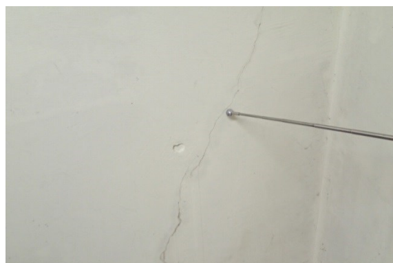
写真 内壁のひび割れ／幅の広いものは要是正
