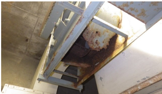
写真 居室用換気設備 破損/要是正
