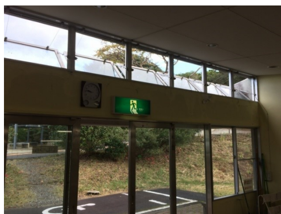
写真 排煙窓 開閉状況
