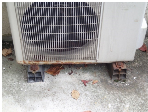
写真 空調機器のサビ/能力低下、異音
