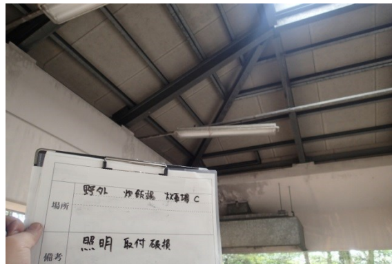
写真 照明取付破損／要是正
