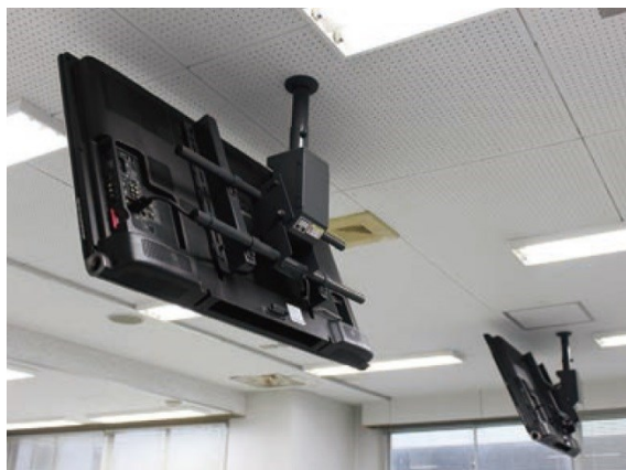
写真 吊りテレビ状況／テレビの重量に不釣り合いな簡易的な施工方法／落下の危険 要是正
