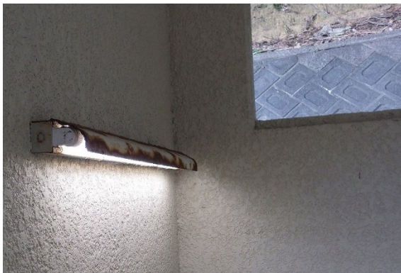
写真 照明器具 劣化／要交換
