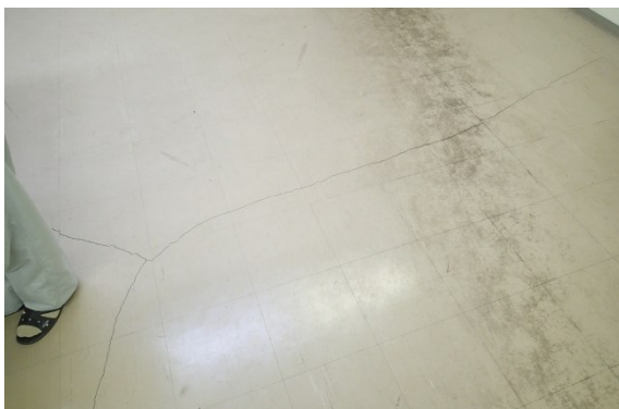
写真 ビニル床タイル劣化状況/要修繕
