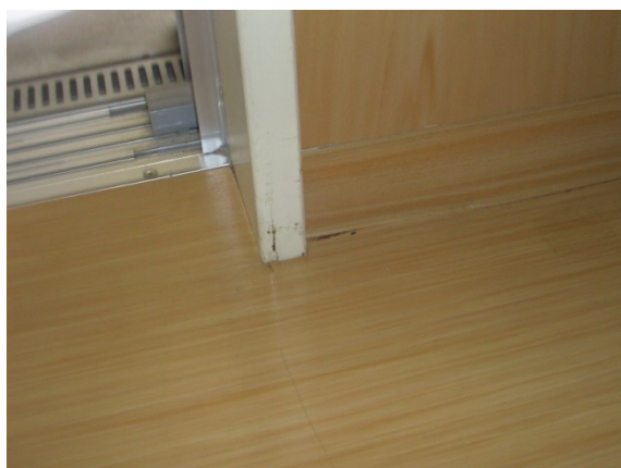
写真 フローリングのささくれ／要修繕
