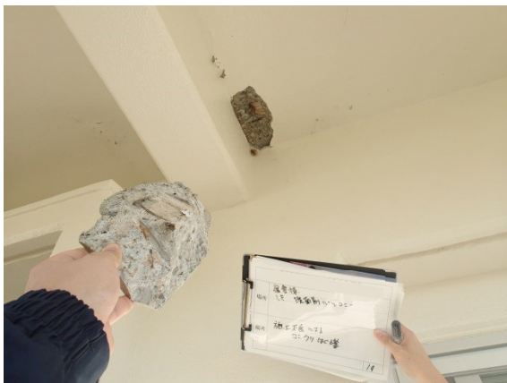
写真 直天井のコンクリートの落下/要是正
