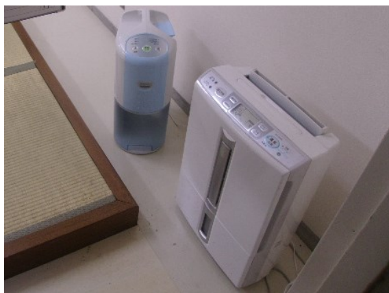
写真 カビの発生のため除湿機を設置
