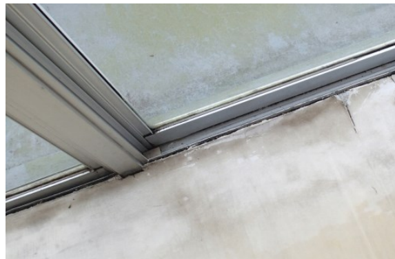
写真 床材はがれ/要補修
