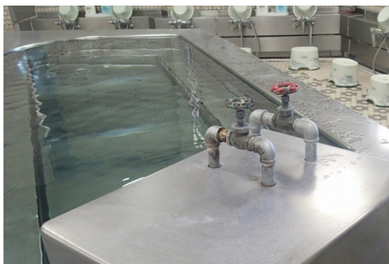
写真 蛇口水漏れ／要修繕
