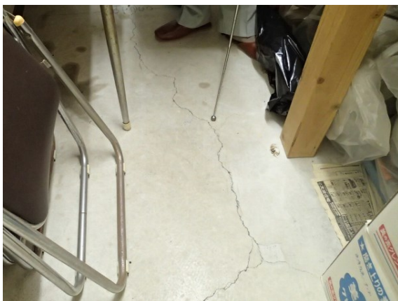
写真 床 ひび割れ／要調査
