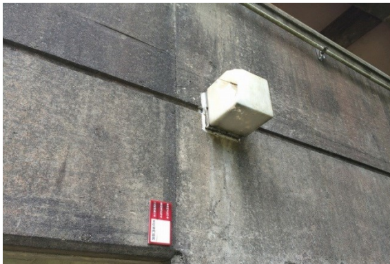
写真 照明器具 破損／要交換
