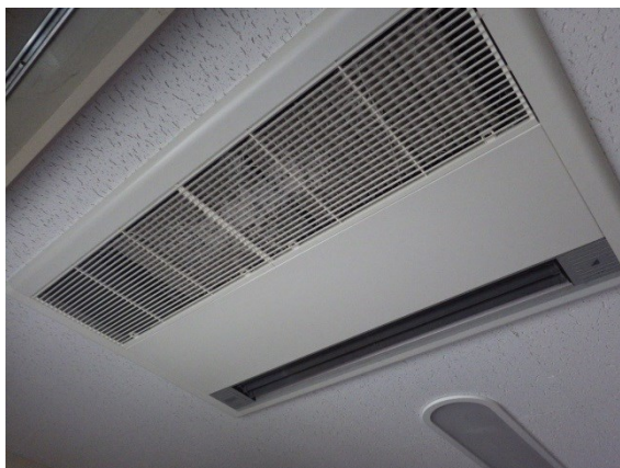
写真 天井設置空調機の除湿運転
