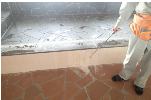
写真 風呂タイル白華／要修繕
