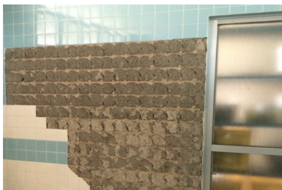
写真 内壁（タイル）のはがれ／要是正
