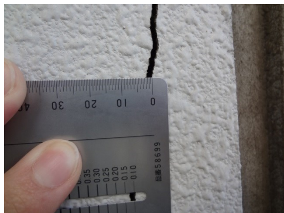
写真 クラックスケールでひび割れの幅を計測
