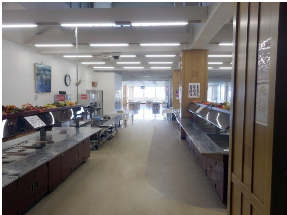
写真 食堂床状況（ワックス施工前）
