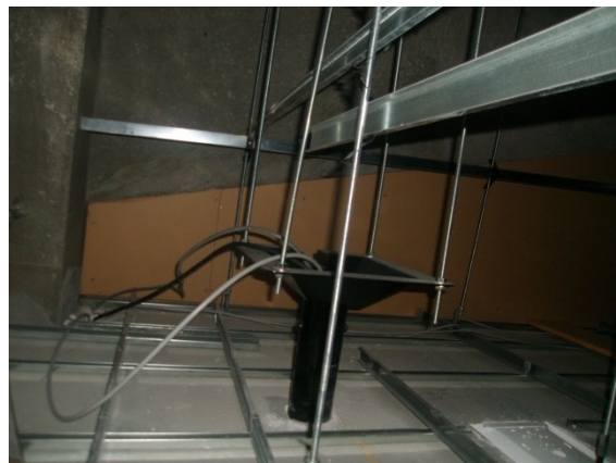
写真 吊りテレビ状況／テレビの重量に不釣り合いな簡易的な施工方法／落下の危険 要是正
