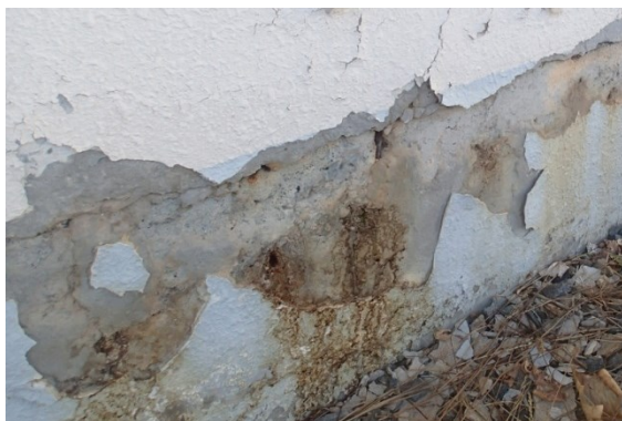
写真 浴室外部爆裂／要調査
