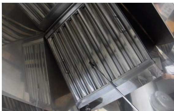
写真 厨房用換気設備状況
