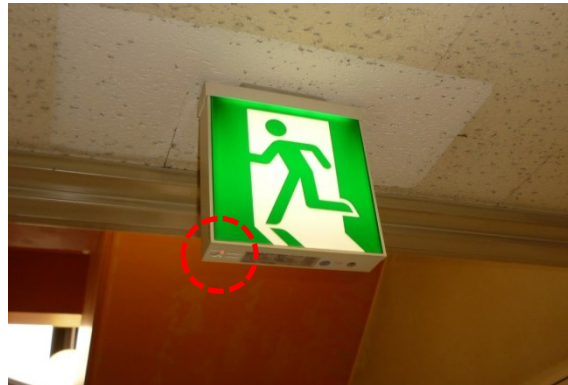
写真 非常用照明バッテリー不足／要バッテリー交換
