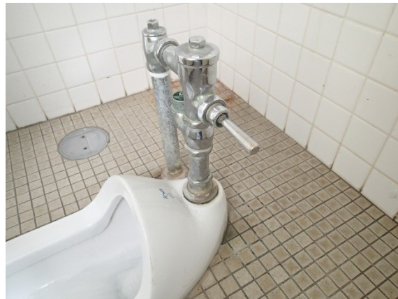
写真 衛生機器(便器)
