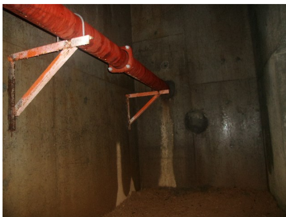
⑥ 地下壁状況 (結露)
