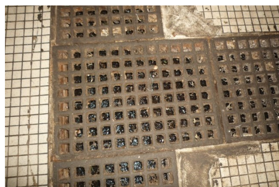
写真 排水溝の未清掃/要清掃
