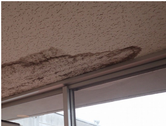
写真 天井材の漏水跡/要是正
