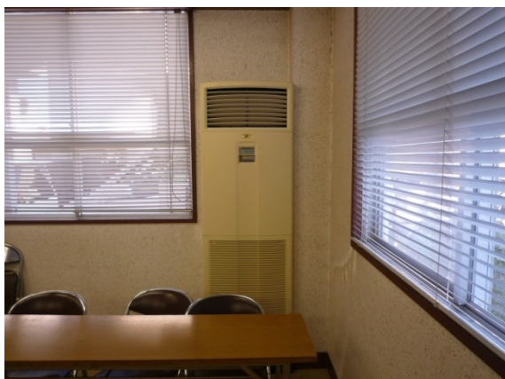
写真 床置き空調機の除湿運転
