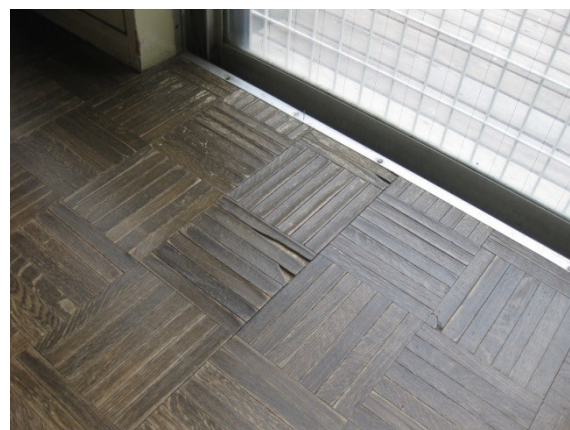
写真 フローリングのはがれ／要修繕
