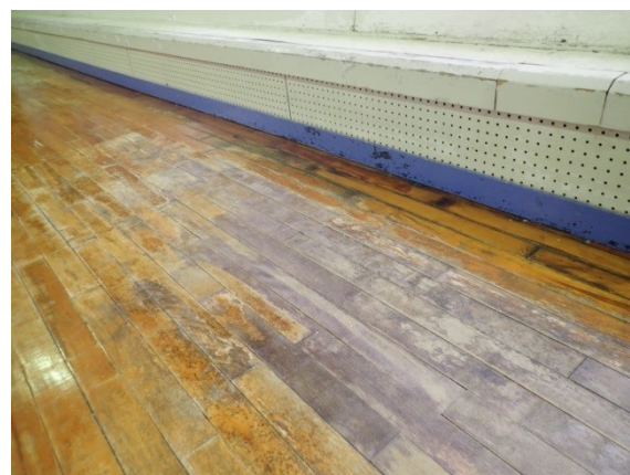
写真 フローリングの劣化／要是正
