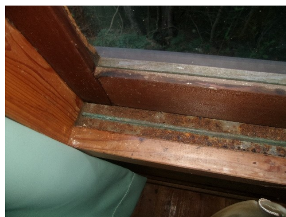
写真 レールのサビによる開閉不良/要補修
