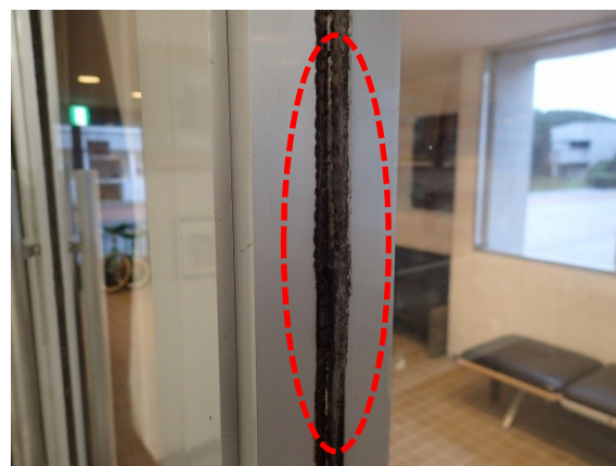
写真 窓ガラスシーリング材劣化/要修繕
