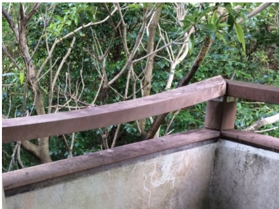
写真 木製手摺の劣化状況／要補修
