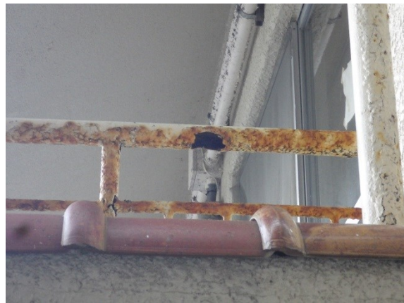
写真 サビにより欠損／要補修
