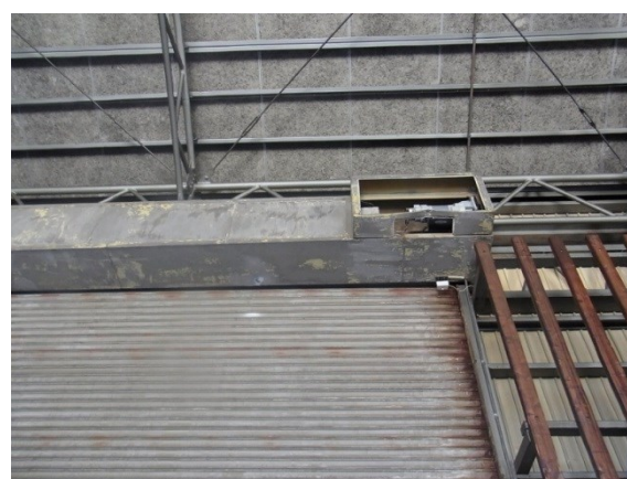
写真 シャッターボックス破損／要修繕
