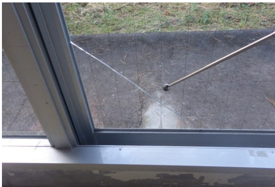
写真 ガラスひび割れ／要交換
