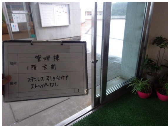
写真 引き残しストッパーがない／指挟み危険
