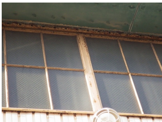
写真 スチール製建具の腐食/要交換
