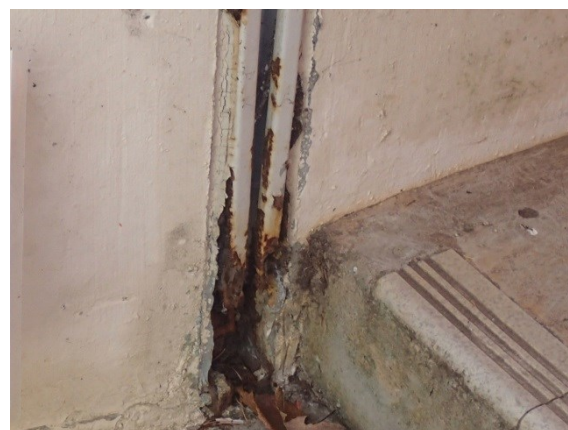
写真 シャッターレール腐食／要修繕
