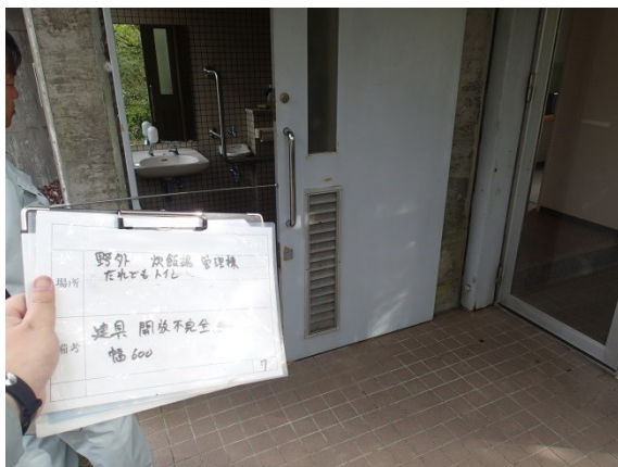
写真 ドアの開口幅不足／要是正
