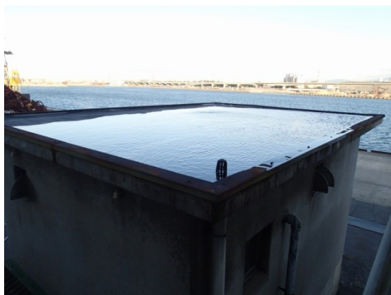
写真 大雨後排水不良状況／要是正
