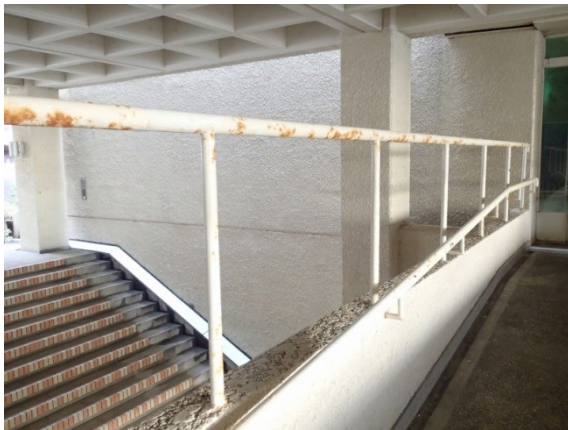
写真 鉄製手摺のサビ／要タッチアップ
