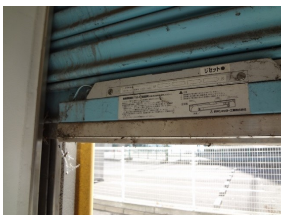
写真 自動閉鎖式シャッターの安全装置／ ない場合は要設置
