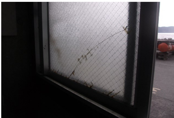
写真 網入りガラスのひび割れ／要交換
