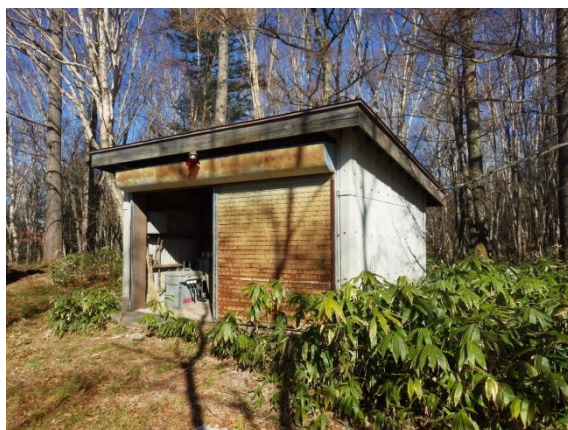
写真 シャッターの錆／要塗装
