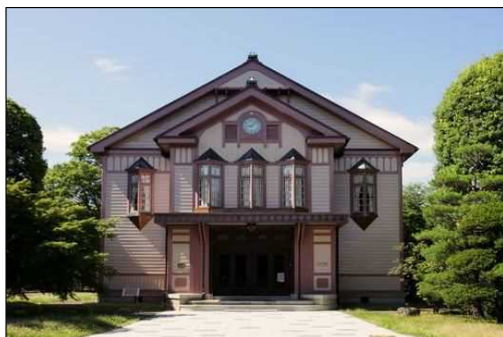
対策前の外観
