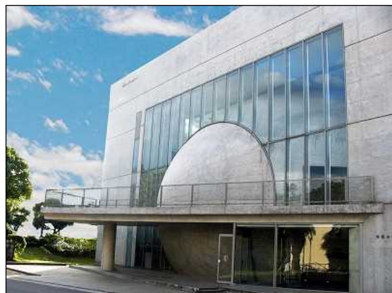
対策前の外観
