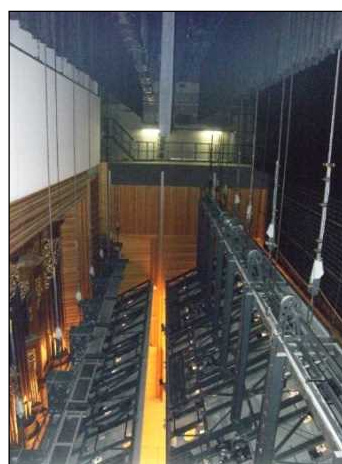
対策前の音響反射板上部
