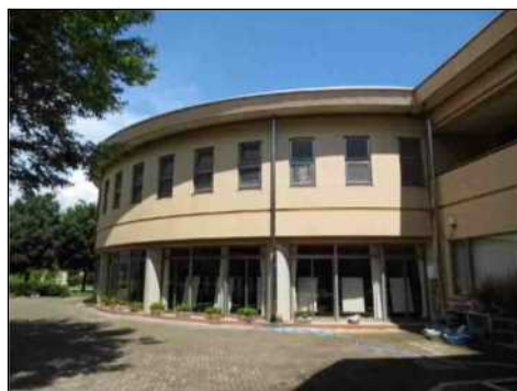
対策前の外観
