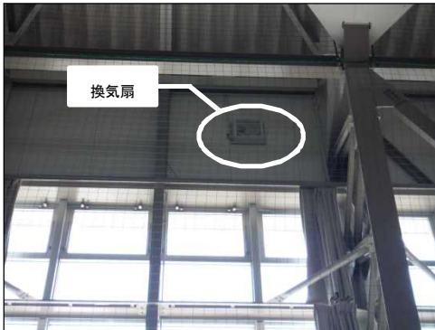
新設の壁付き換気扇（遠景）
