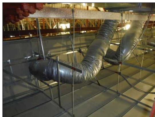
対策前の天井裏(換気ダクト外)
