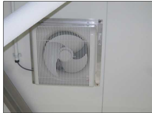
新設の壁付き換気扇（近景）
