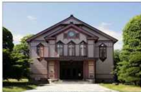
対策前の外観
