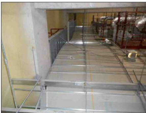
対策前の天井裏
