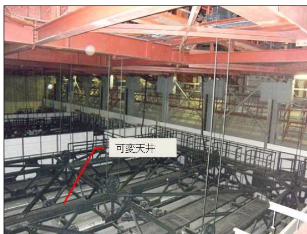
対策前の可変天井上部
