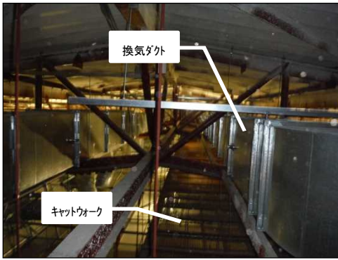
既設のダクトとキャットウォーク
