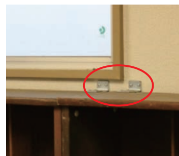
棚の耐震対策 (壁に金具で固定)
