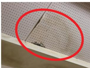
写真1. 天井材のしみ、破損
