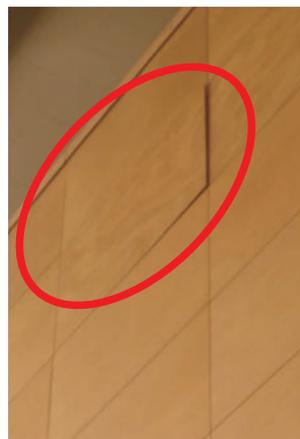
写真5. 内壁のずれ
