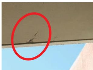
写真2. 階段裏のひび割れ
