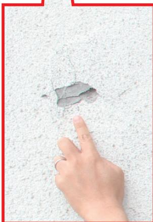
写真3. 外壁の浮き、剥落
