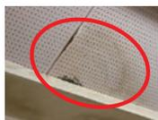
写真1. 天井材のしみ、破損
