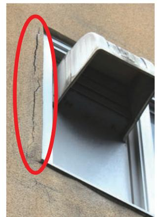
写真6. 外壁のひび割れ
