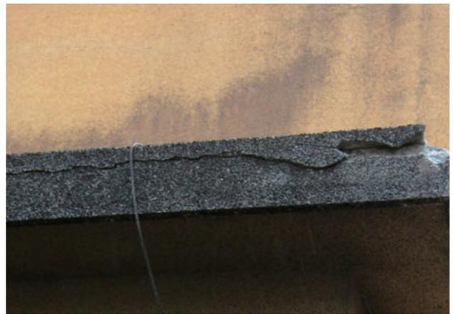
写真2. 外壁（庇の先端部）のひび割れ、欠損
