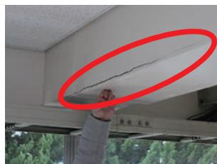
写真3. 梁の仕上げ材のひび割れ
