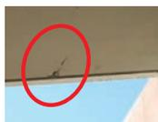
写真2. 階段裏のひび割れ
