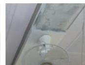
写真4. 梁のモルタルの脱落
