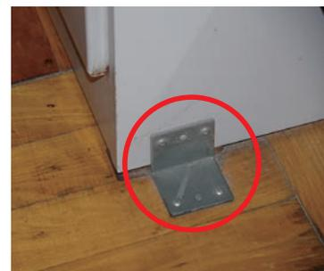
写真 2. 棚の下部を床に固定した例
