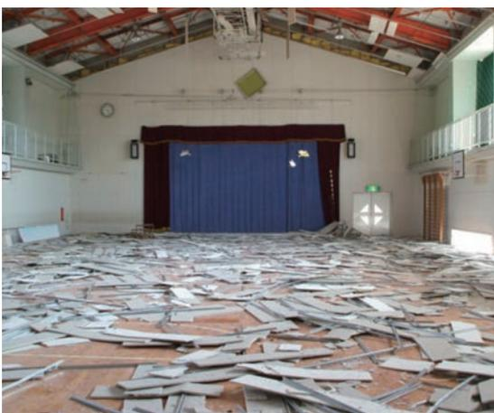
屋内運動場の天井材の脱落
