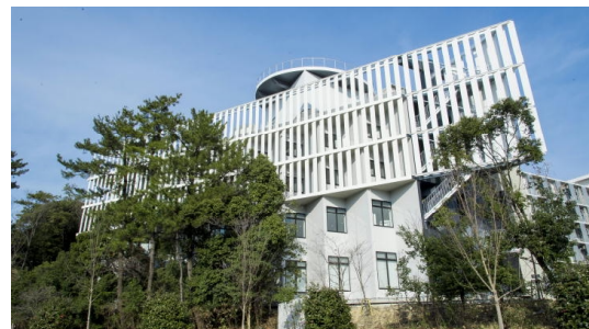
西側外観：西面には開放感確保しながら、西日遮蔽のためルーバーを設置し、夏場の高い太陽は庇（ひさし）で遮り、冬場の低い太陽は取り込むよう計画し、熱負荷による影響を低減している。
