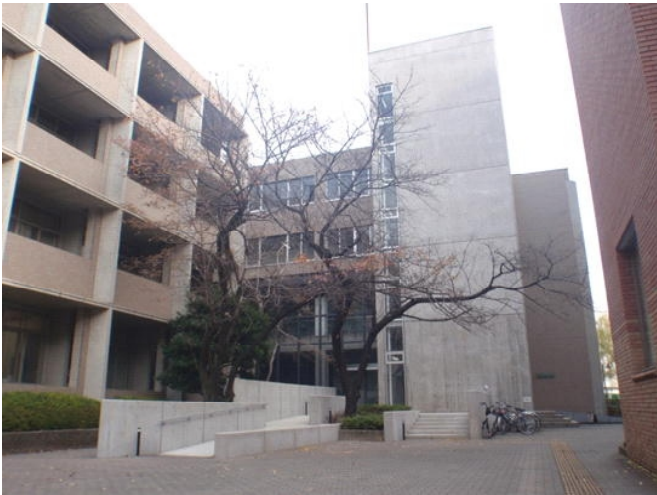
南側外観（手前は3号館）
