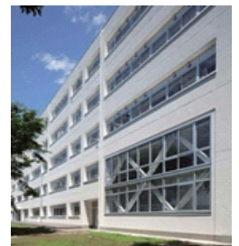
2層耐震ブレース
