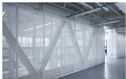
耐震ブレースをパンチングメタルで覆った展示壁
