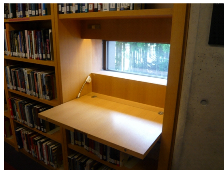
背板を引き倒すことで自然採光と机の機能が生まれる書架
