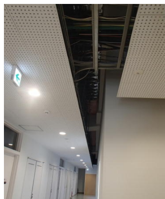
天井メンテナンススリット
