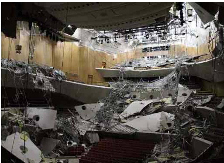
音楽ホールにおける天井の脱落
