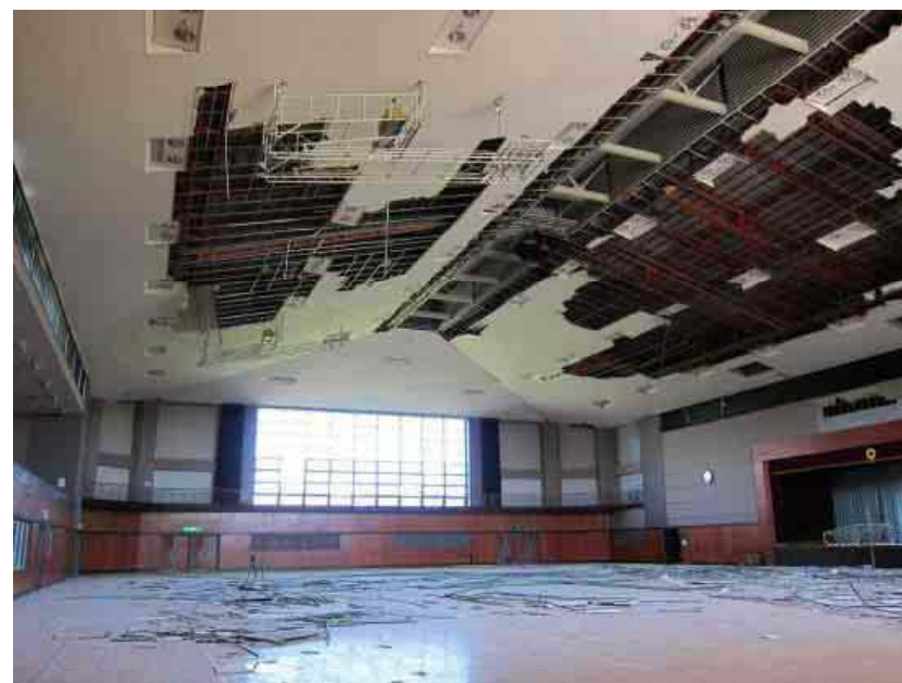
体育館における天井の脱落
