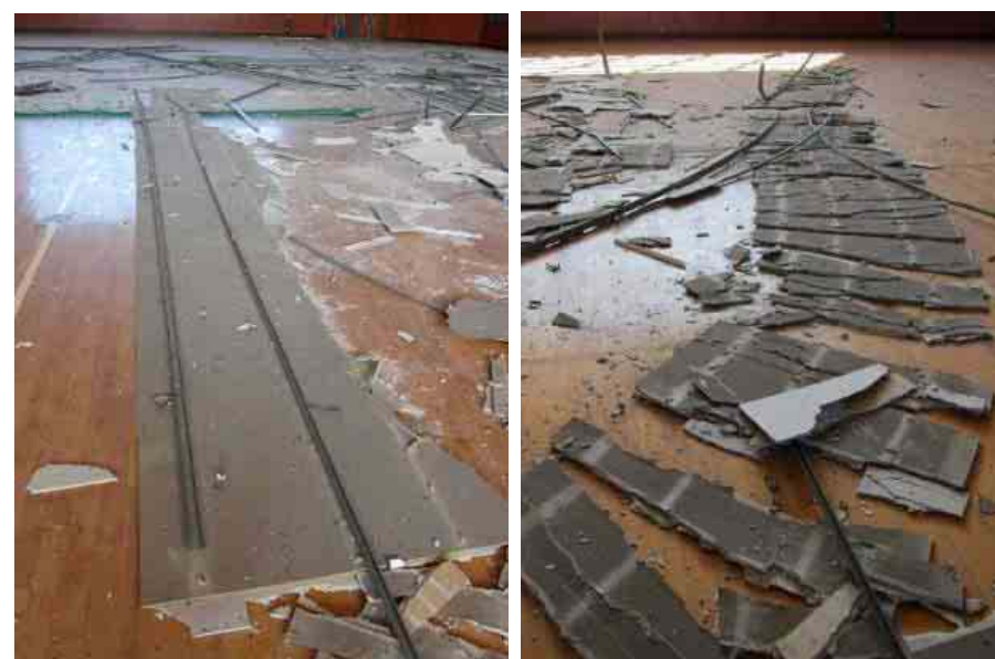
脱落した天井部材
