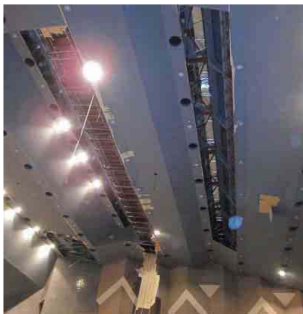
ホールにおける天井の脱落
