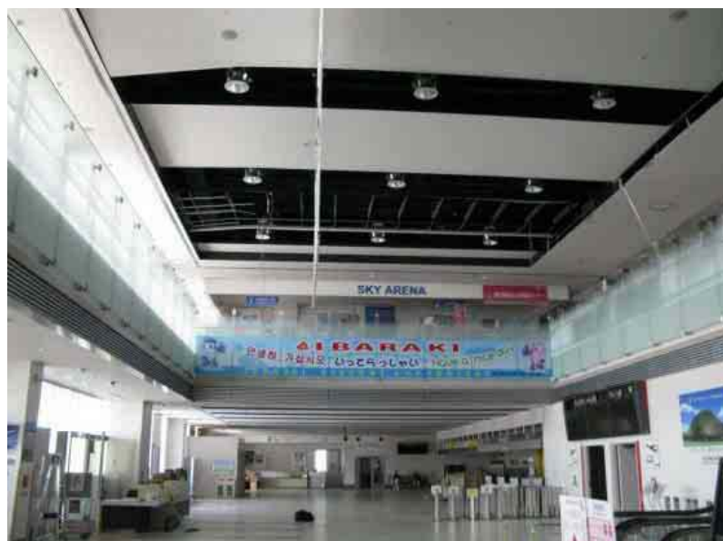
旅客施設における天井の脱落
