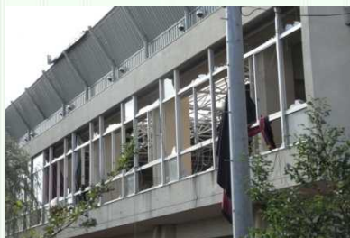
ガラスの破損
