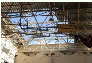
屋根材の破損(内観)
