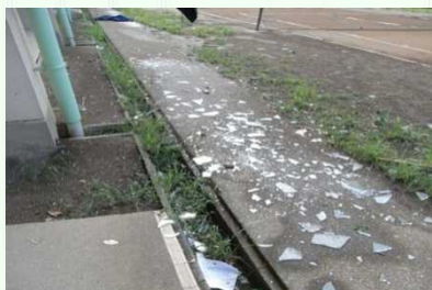
ガラスの破損
