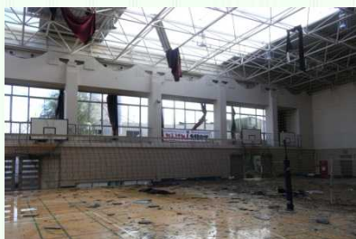
屋根材の破損(内観)
