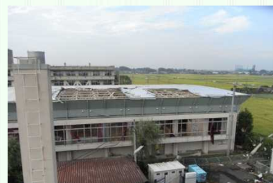
屋根材の破損(外観)
