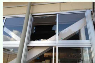
強化ガラスの破損
