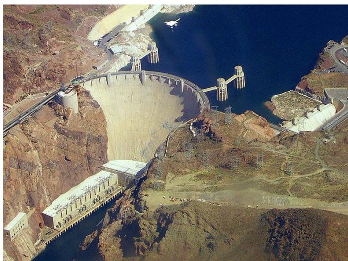
フーバー・ダムは、アメリカ合衆国コロラド川のブラック峡谷にある、高さ221mのアーチ重力式コンクリートダムである。このダムは、灌漑用水の供給、洪水調節、およびダム基部の水力発電所への水の供給を目的として建設された。
