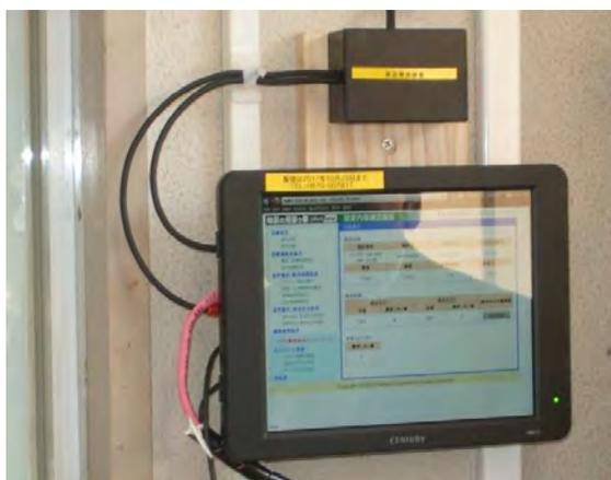
【設置した緊急地震速報受信システム】
