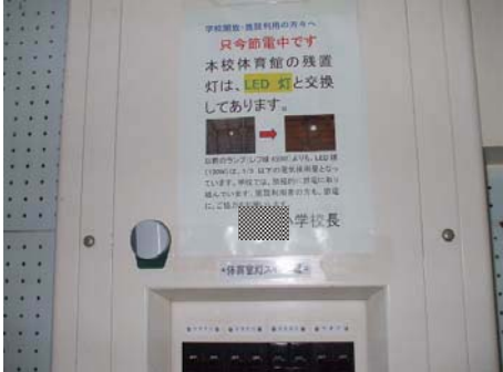
ポスターの写真 (分電盤付近)
