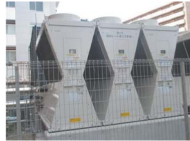
高効率モジュール型空冷ヒートポンプチラー
