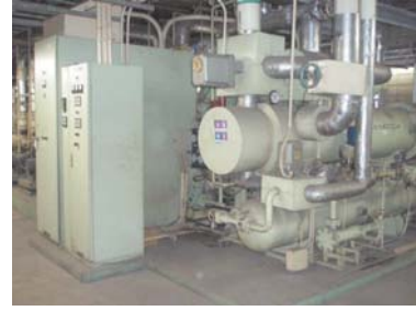
セパレート型空冷ヒートポンプチラー
