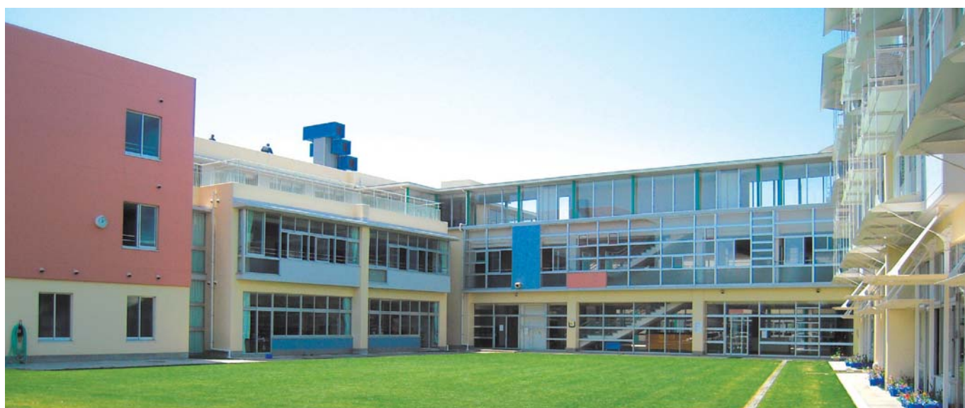
サブグラウンド（芝生の中庭）に連続した普通教室とメディアセンター
