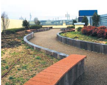
6 面積約430㎡の屋上緑化スペース
