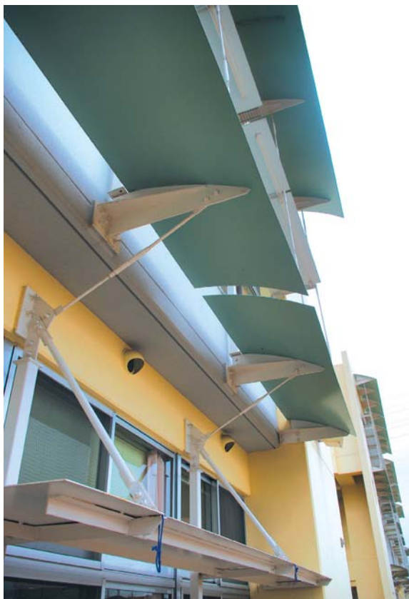
5 日射をコントロールする庇と室内に光を反射させるライトシェルフ
