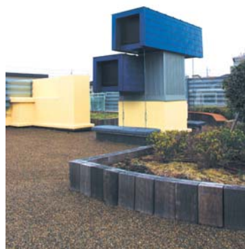
9 自然換気(重力換気)の排気口となる「風の塔」
