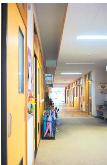
8 「風の道」の廊下上部の勾配天井により「風の筒」入口へ熱気を誘導
