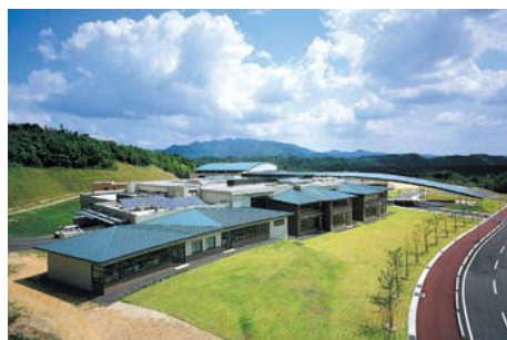
12 太陽光発電システム
