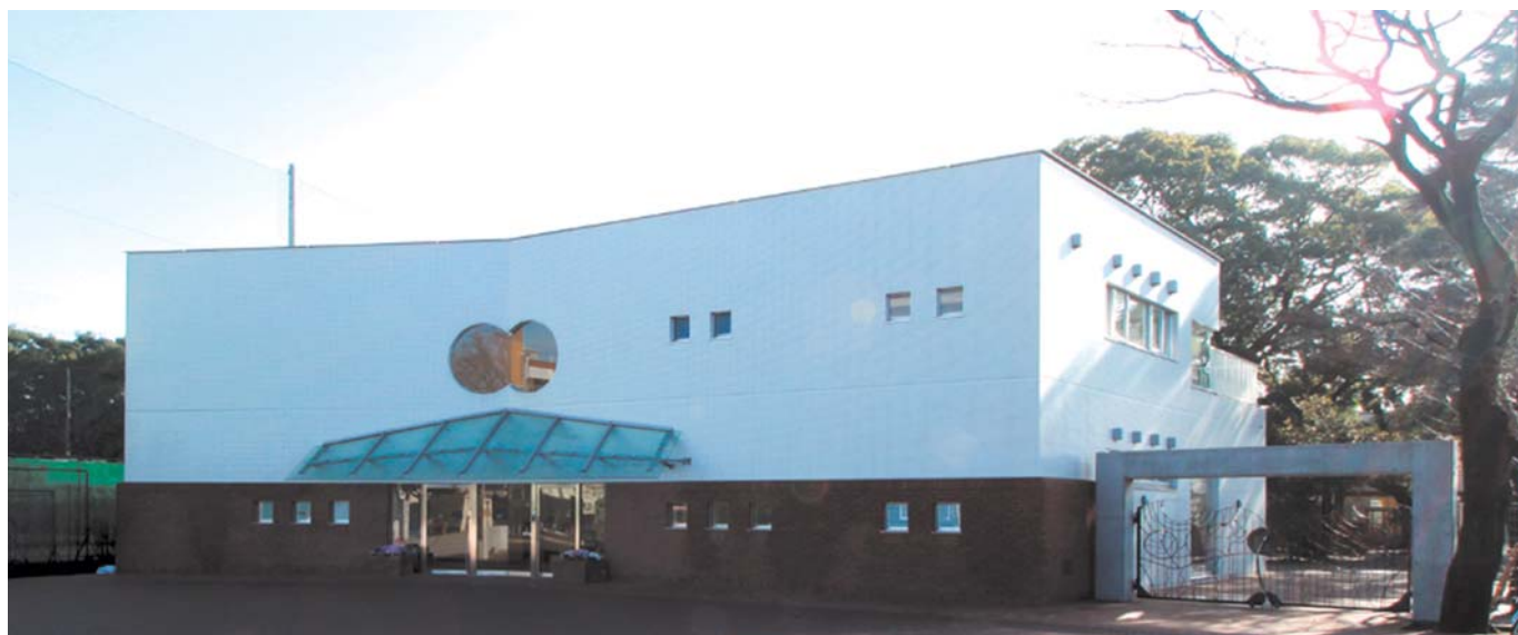
緑に囲まれ、外部との接点を限定し、安心・安全に配慮した園舎
