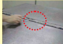
× 洗浄不足の調理台 継ぎ目部
