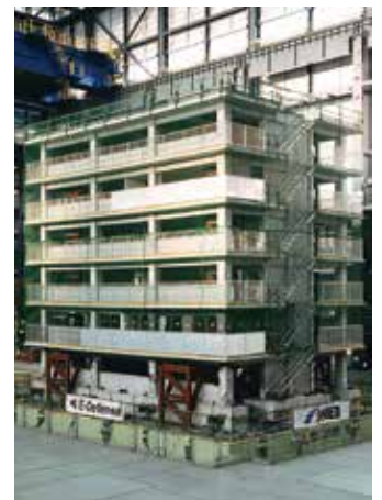
実大三次元震動破壊実験施設「E-ディフェンス」(提供：防災科学技術研究所)
