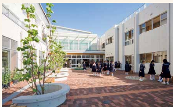
老朽化した古い校舎を良好な教育環境に改修
