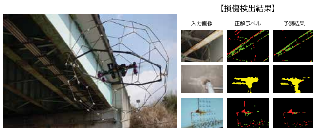
研究開発中の自律飛行ドローン及び深層学習に基づくインフラ構造物の損傷箇所自動検出技術 （提供：理化学研究所、東北大学）
