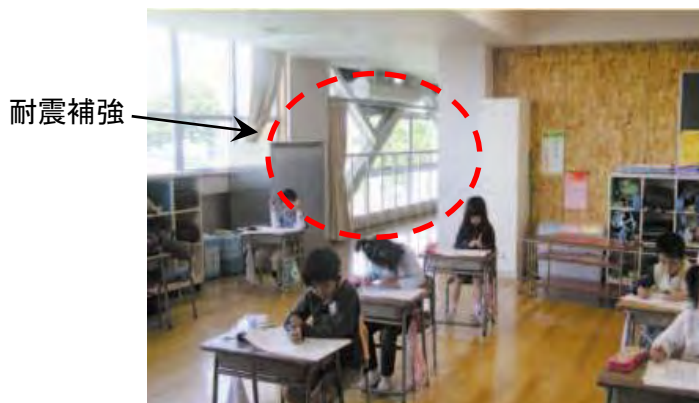
耐震補強にあわせた改修事例
