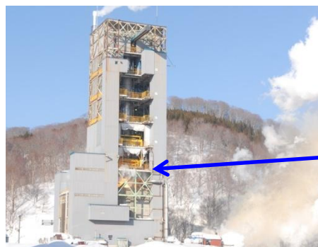
厚肉タンクステージ燃焼試験
