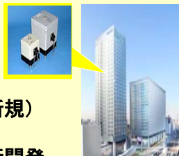
建物への地震観測システムの設置
