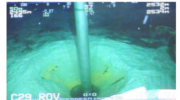
「ちきゅう」による長期孔内観測装置の掘削孔への設置の様子
