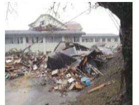
東北大学(建物の損壊)
