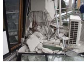
東北大学(柱の破壊)
