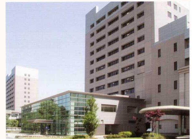
左奥：研究棟Ⅰ、左手前：2号館、中央：工学部百周年記念館、奥：総合研究棟、右：研究棟Ⅱ-1
