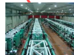
大阪大学 LFEXレーザー
