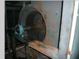
空調機内部劣化
