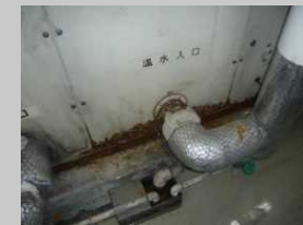
空調機から漏水
