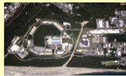
特定中性子線施設 J-PARC中性子線施設
