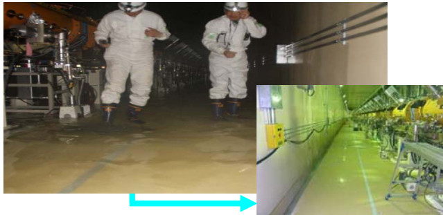
加速器トンネル内が地下水により10cm浸水 (1次補正:53百万円)
