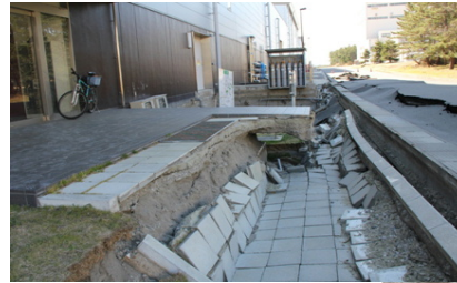
施設周りが1m以上陥没 道路は数十cm盛り上がり
