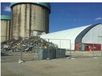
○テント内で放射性廃棄物を処理している。 ○テント外は一般廃棄物の扱い ○他に汚染水処理施設も設置されている。
