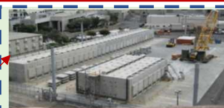
施設の拡張(2,3号機のすべてのSF貯蔵)
