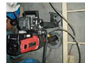
コンクリート試料の取出
