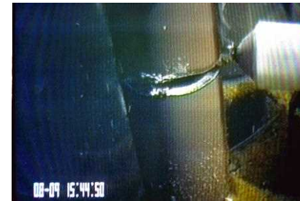
プラズマアーク切断装置による制御棒ガイドチューブの切断
