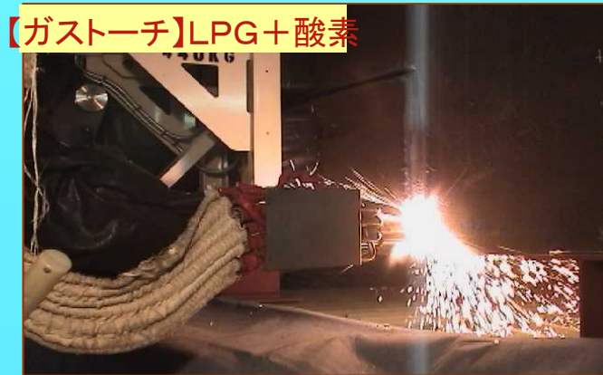
熱交換器胴部の熱的切断作業
