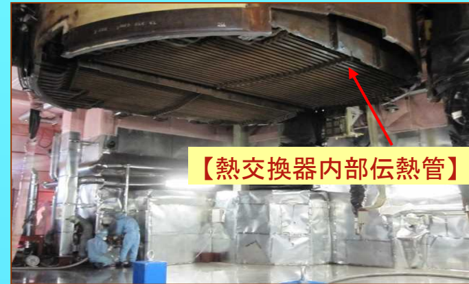
熱交換器ティア切断状況
