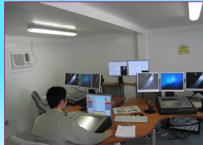
遠隔解体装置操作室
