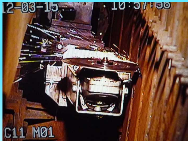
熱交換器内部構造物の機械的切断作業
