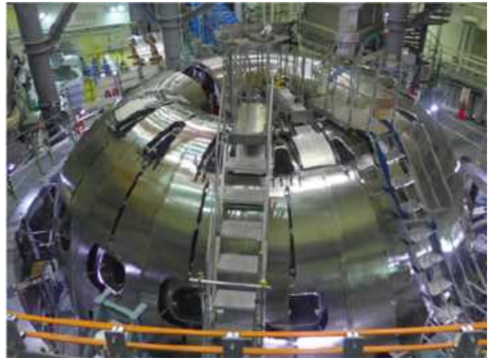
順調に進む真空容器&熱遮蔽の組み立て(2016年6月)
