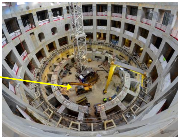
トカマク設置場所(2018年8月)
