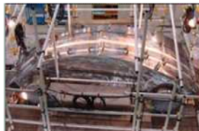
③モックアップ溶接試験
