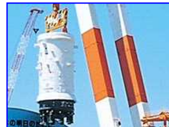
原子炉圧力容器据付
