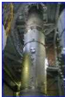
静的安全系試験設備
