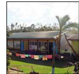
同小学校内で大きな被害がなかった「JICAビルディング」
