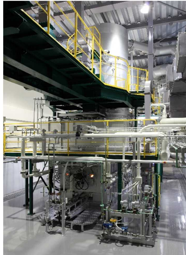
■ 有機液体・動物焼却処理設備
