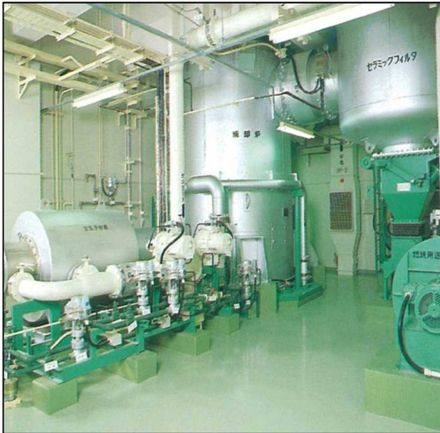
■ 焼却処理設備
