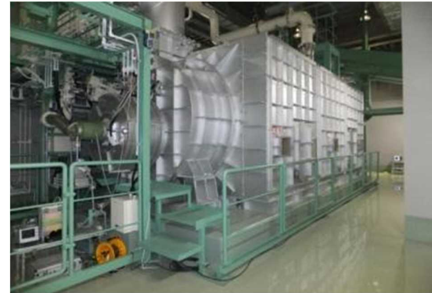
■ 仮焼処理設備
