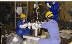
設備機器の点検及び更新
