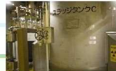
スラッジタンク
